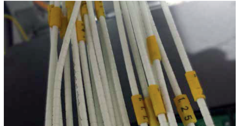
Identification des câbles
