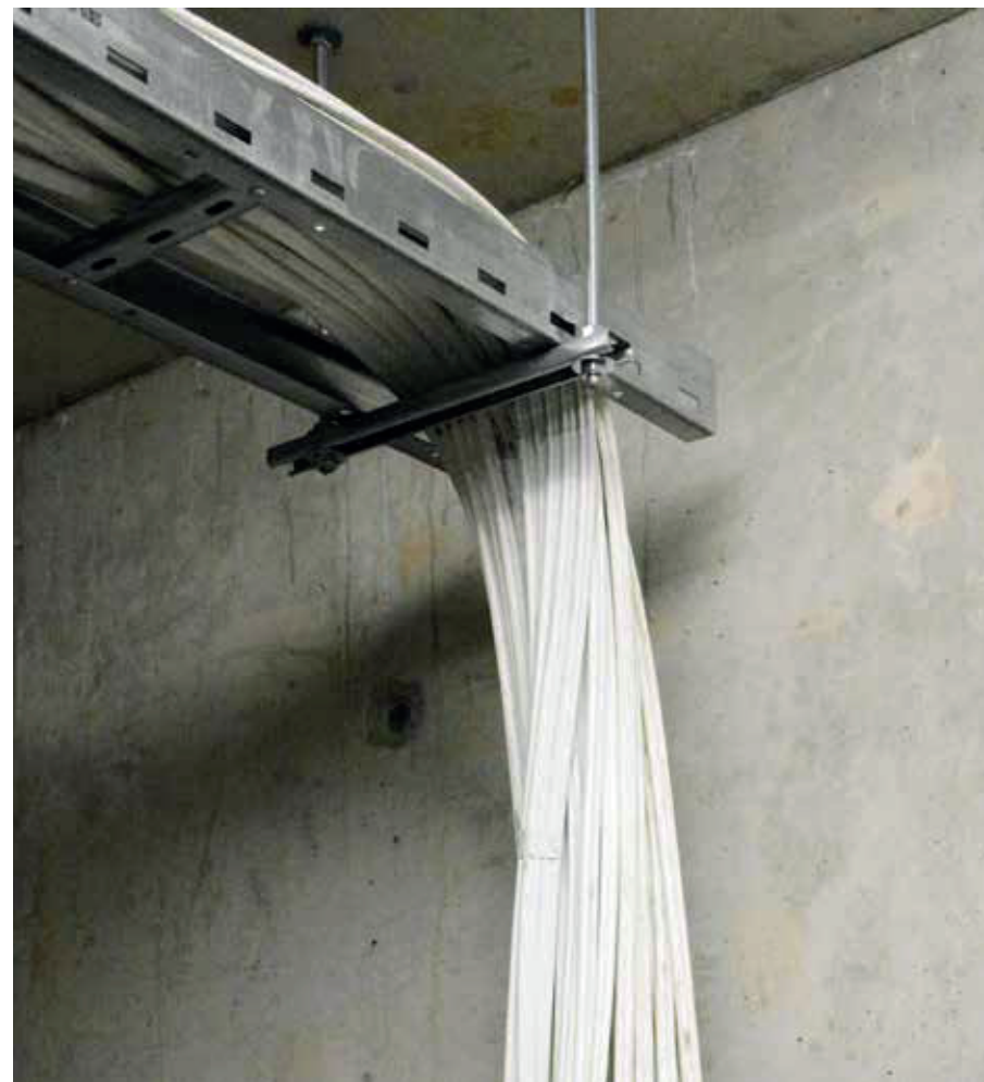
Échelles de câbles
